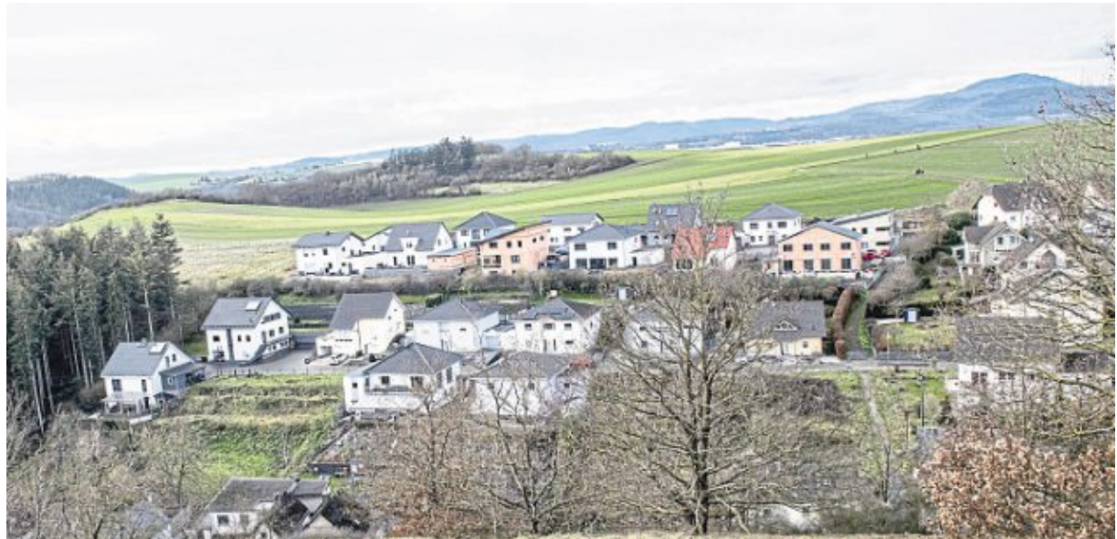
Die Gemeinde Trimbs wird die Schieferstraße (oben links) um 200 Meter in Richtung des Fichtenwäldchens erweitern. Die Erschließungsstraße wird aller Voraussicht nach im Herbst 2021 gebaut.
